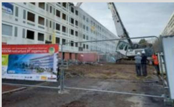
Le chantier de réhabilitation de la résidence Schuman à Poitiers a favorisé la réutilisation de façades métalliques en rangement pour vélo. Ce chantier a également permis le recyclage des fenêtres ainsi que du béton (à hauteur de 30%) issu de démolition, traité et conditionné sur la plateforme BTP recyclage, puis réacheminé sur le chantier pour réutilisation. Ce chantier a bénéficié d'une synergie inter filiale et d'un contexte local favorable (circuit court).
