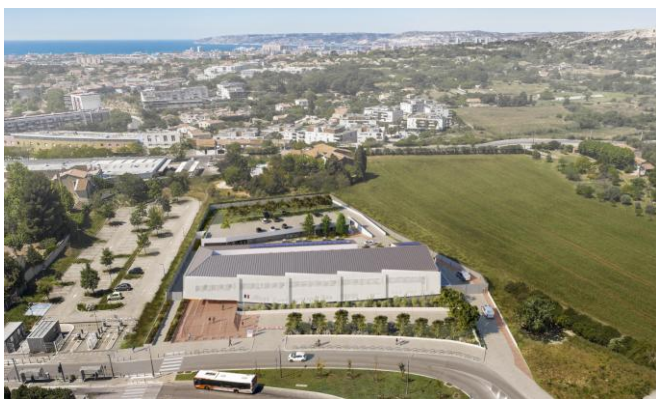
Crédit photo : HELLIN-SEBBAG-PIRANY (HSP) Architectes et Atelier Perez Prado
