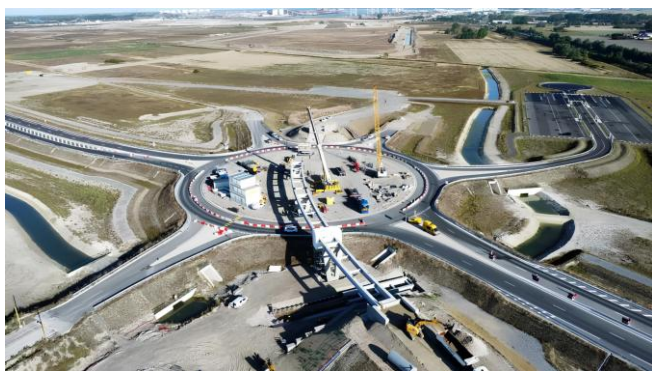
Viaduc du Grand Port Maritime de Dunkerque (59) Crédit photo : Grand Port Maritime de Dunkerque
