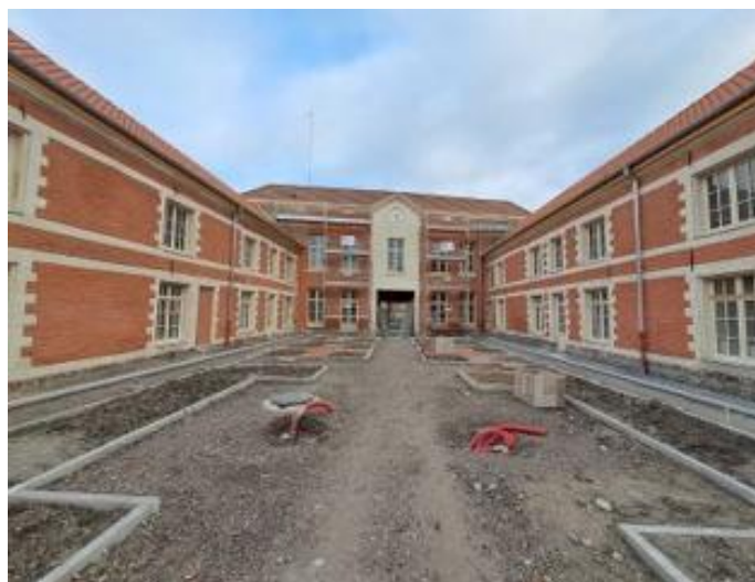
Centre Hospitalier Les Chartriers de Valenciennes (59) Maes Architecte Urbaniste- Crédit photo : Spie batignolles
