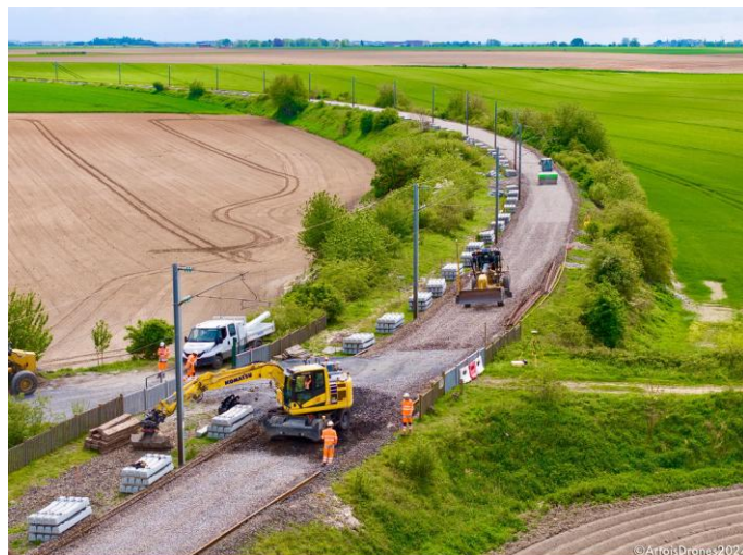
Ligne ferroviaire entre Cambrai et Douai (59) Crédit photo : ArtoisDrones
