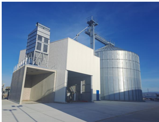
Silo à pellets pour Total Energies à Strasbourg (67)
