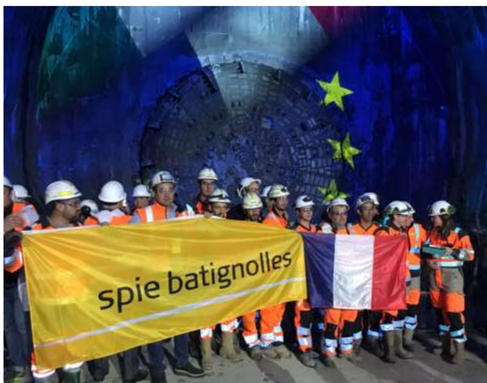
Chantier de la galerie de reconnaissance de Saint-Martin-La-Porte – Copyright : Spie batignolles
